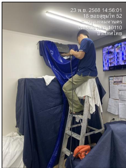
รูปภาพที่ 2.38 การล้างทำความสะอาดเครื่องปรับอากาศ
