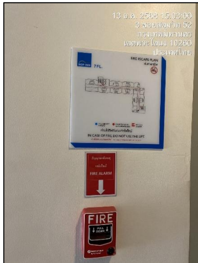
อุปกรณ์แจ้งเหตุด้วยมือและอุปกรณ์แจ้งเหตุพร้อมเสียงและแสง
